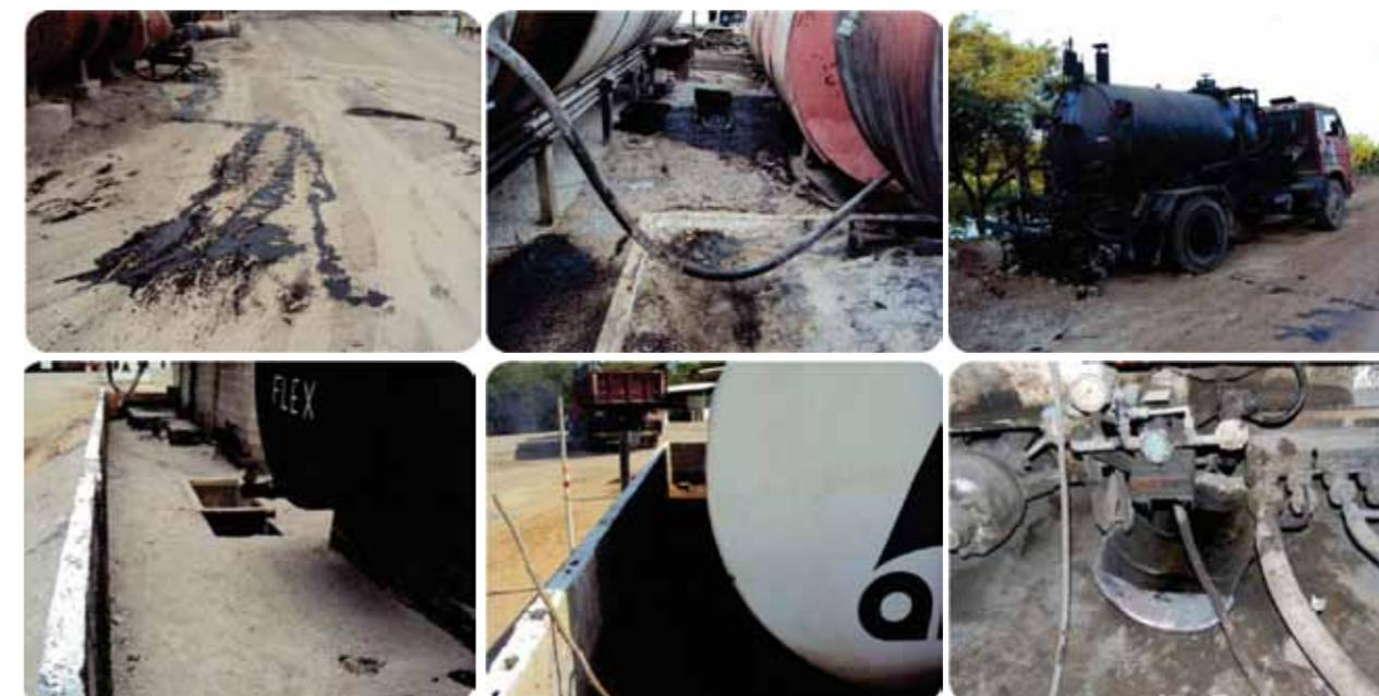
Figuras 31, 32 e 33 (acima) – Vazamento de óleo – Obras na BR-262/MS
