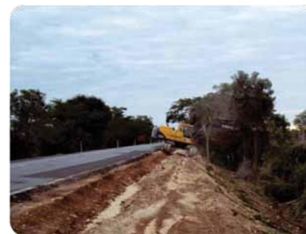
Figura 10 – BR 262/MS – Supressão de vegetação para implantação de acostamentos – BR-262/MS – Trecho Anastácio Corumbá.
