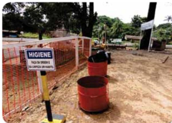
Figura 14 – Acondicionamento temporário de resíduos no canteiro de obras da ponte sobre o Rio Madeira – BR-319/RO.
