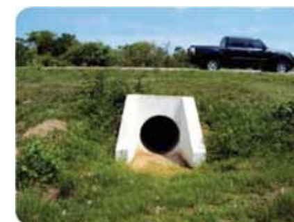
Figuras 52 e 53 – Dispositivo de drenagem: Bueiro de Concreto – Obras na BR-262/MS.
