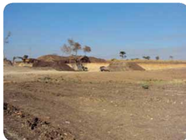
Figura 9 – Área de empréstimo de materiais para aterro – BR-262/MS – Trecho Anastácio Corumbá.
