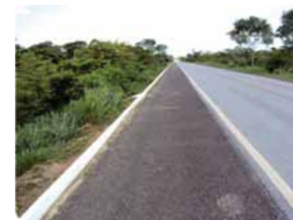
Figuras 50 e 51 – Dispositivo de controle de deflúvio: Tipo Meio-Fio – Obras na BR-262/MS.
