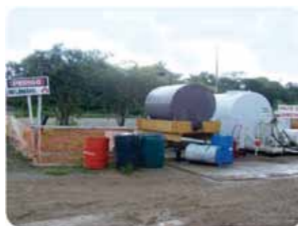
Figura 28 Depósito de combustível – Obras na BR-230/TO/PA – Ponte sobre o Rio Araguaia.
