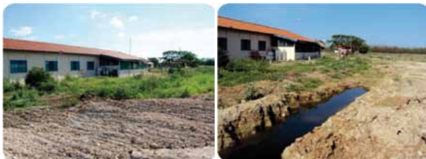
Figuras 58 e 59 – Valetas de drenagem: antes e depois de ser reaterrada – Obras na BR-262/MS.
