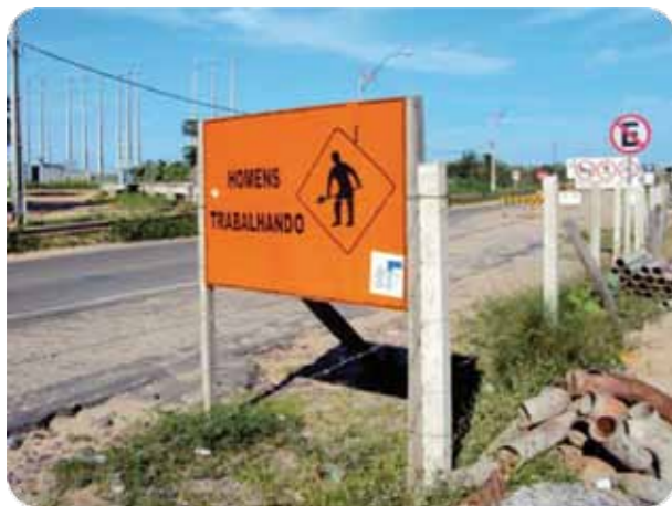
Figura 13 – Sistema de sinalização das obras sobre o Rio Jaguaribe, Aracati (CE).
