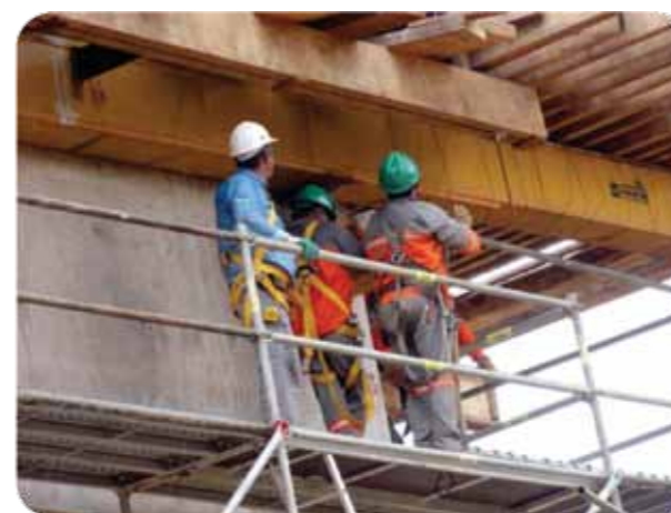
Figura 18 – Operários da obra da ponte sobre o Rio Madeira – BR-319/RO.
