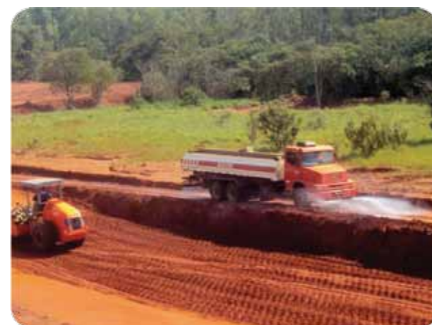
Figura 11 – Caminhão de aspersão de água – BR-487/PR – Estrada Boiadeira.
