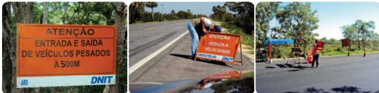
Figuras 41, 42 e 43 (abaixo) – Sinalização do trecho em obras – Obras na BR-262/MS.
