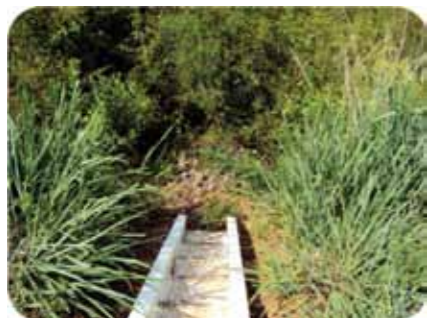
Figura 54 – Dispositivo de drenagem: Descida d'Água Tipo Escadaria – Obras na BR-262/MS.
