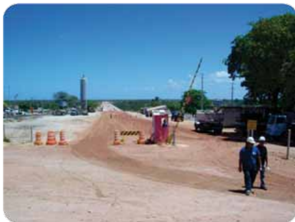
Figura 8 – Canteiro de obra da construção da ponte sobre o Rio Jaguaribe, Aracati (CE).
