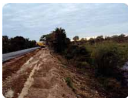
Figura 66 – Uso de escavadeira na supressão vegetal ao longo da rodovia.
