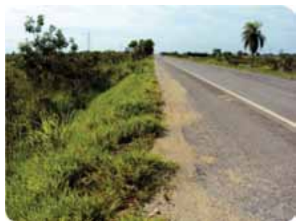
Figuras 55 e 56 – Taludes com cobertura vegetal – Obras na BR-262/MS.
