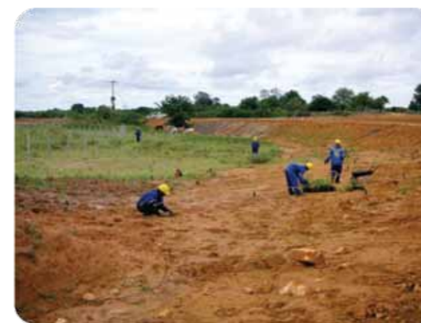
Figura 19 – Plantio para recuperação de área degradada na obra da ponte sobre o Rio São Francisco – BR-030/BA.
