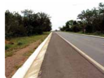
Figuras 48 e 49 – Dispositivo de controle de deflúvio: Tipo Sarjeta – Obras na BR-262/MS.
