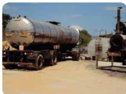
Figura 27 Caminhão especial utilizado pela distribuição de combustível – Obras na BR-262/MS.
