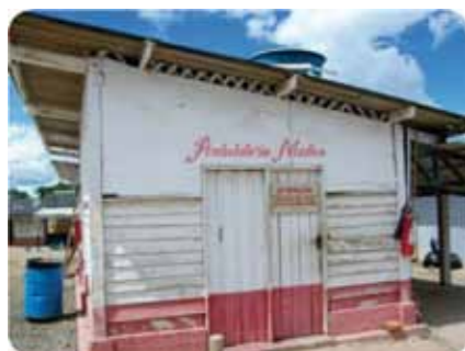
Figuras 44 e 45 Ambulatório e ambulância – Obras na BR-230/TO/PA – Ponte sobre o Rio Araguaia.
