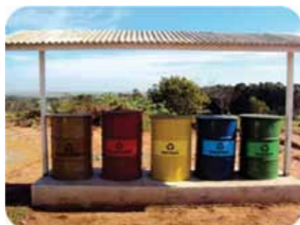
Figura 57 – Tambores para armazenamento de resíduos sólidos não perigosos, conforme CONAMA 275/01 e NBR 11.174/90, nas obras de implementação e pavimentação do Lote 3, BR-487/PR – Estrada Boiadeira.
