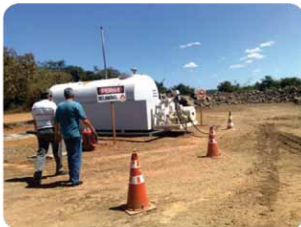
Figura 17 – Área isolada e sinalizada para armazenamento de combustível no canteiro de obras da ponte sobre o Rio Araguaia – BR-230/TO/PA.
