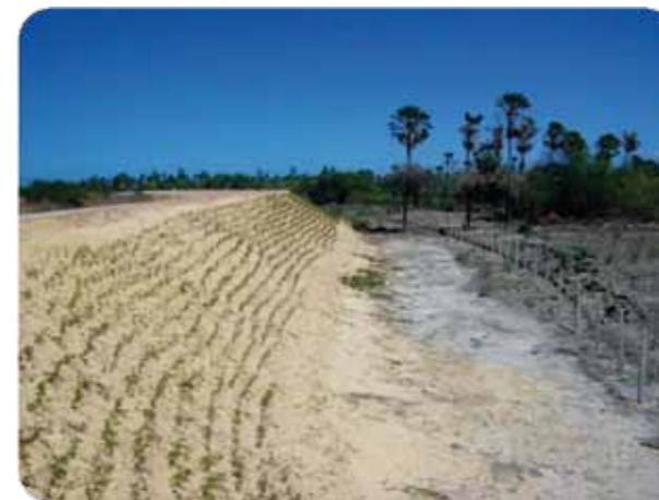
Figura 15 – Aterro de acesso a ponte sobre o Rio Jaguaribe – BR-304/CE.
