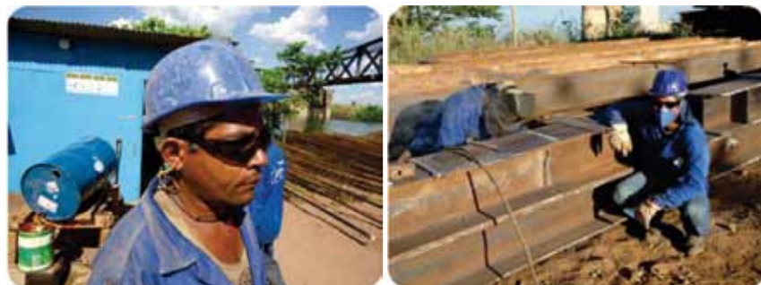
Figura 39 e 40 (acima) – Utilização dos EPI's – Obras na BR-262/MS/SP – Ponte sobre o Rio Paraná.
